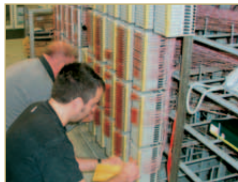
Projektmitarbeiter installieren die neue Telefonanlage.
